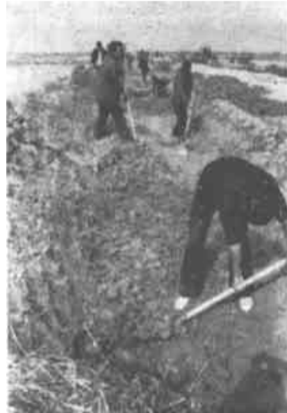
东营区辛店镇茶坡村早计划、早动手，发动群众大搞农田水利建设，到目前，已上劳力400多人、完成土方15000立方，清理沟渠10多条。（崔丽英 摄）
